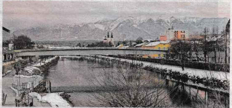
Der Aufgang weist schwere Mängel auf: Nun soll in erster Priorität die Stiege um rund 190.000 Euro saniert werden.
