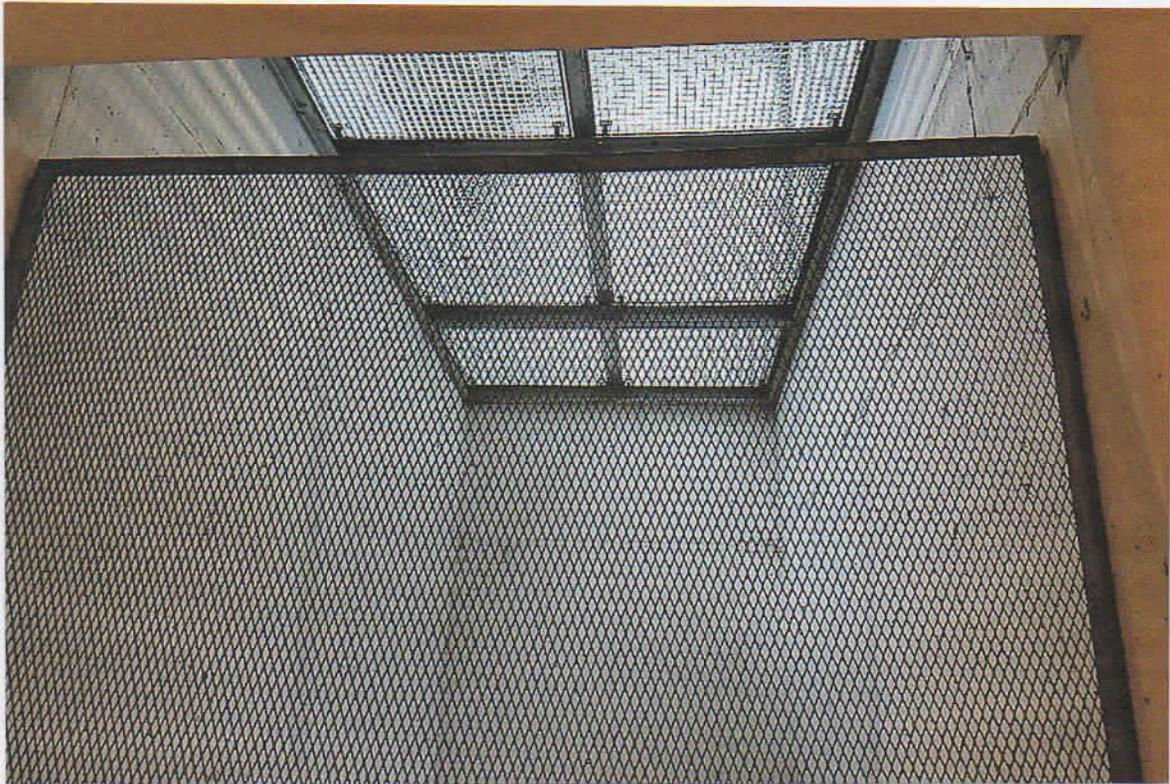
1.UG: Vertikales Liftschachtgitter mit 30 cm Zwischenraum zur Decke,
