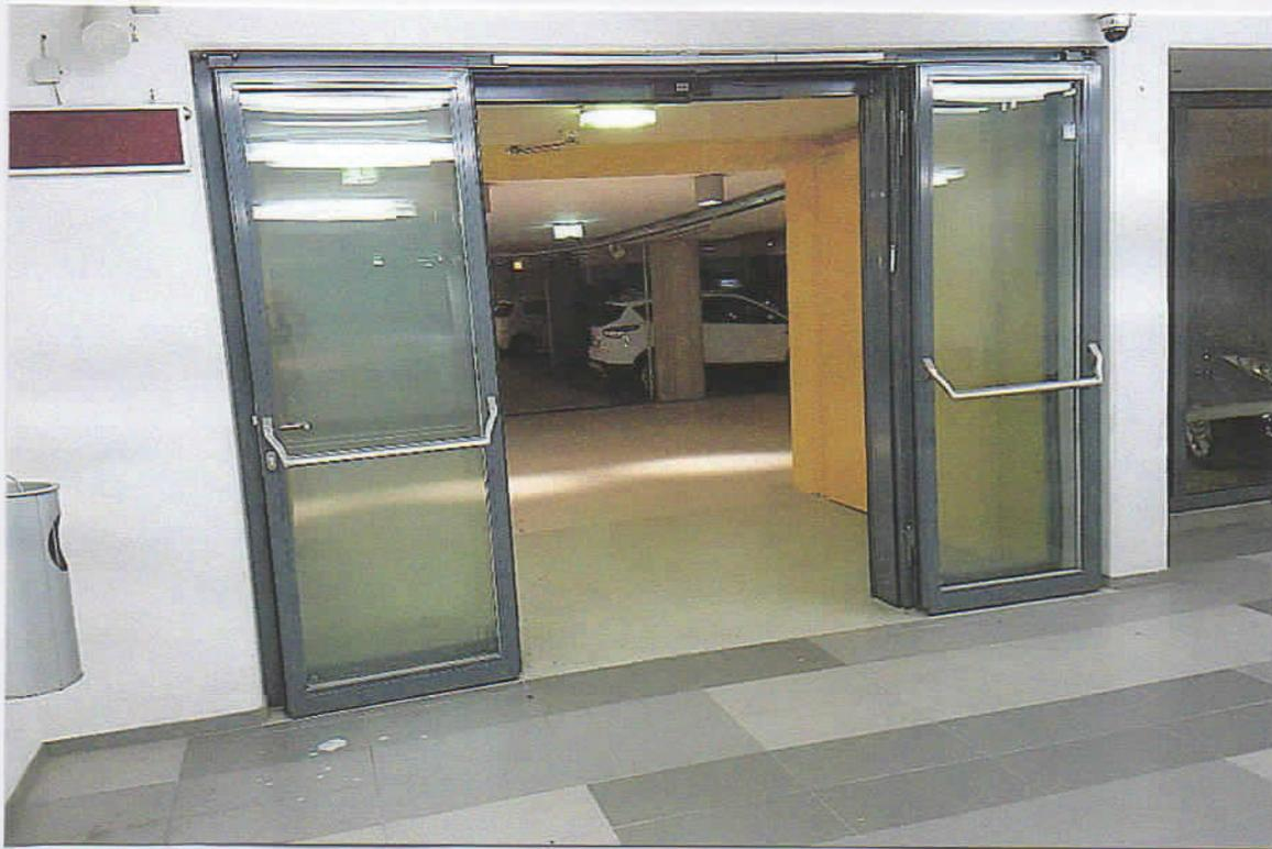
2.UG: Glasschiebetüre zwischen Garage und Stiegenhaus ist dauerhaft geöffnet, nicht als Brandabschnittswand ausgebildet
