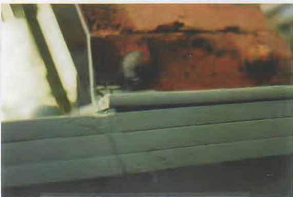
Steher Fußpunkt, Verformung des L - Profils durch Hitzeinwirkung
