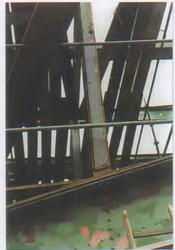
Genieteter Bogenobergurt "verstärkt" durch angeschraubte Laschen, genieteter Steher "verstärkt" durch aufgeschweißte Laschen
