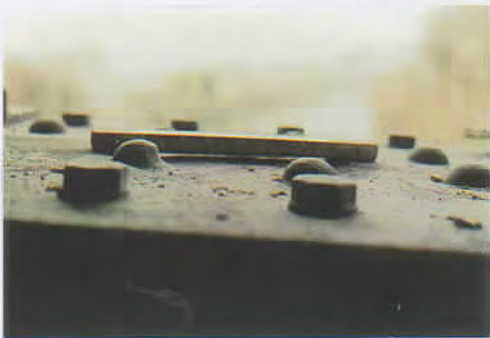
Oberfläche des Bogengurtes, große Fläche auf ca. 6 mm Tiefe mit Hitzeinwirkung ausgeschürft
