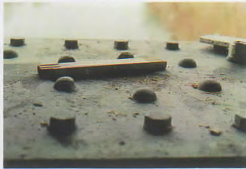
Oberfläche des Bogengurtes, große Fläche auf ca. 6 mm Tiefe mit Hitzeinwirkung ausgeschürft
