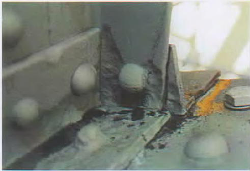
Fußpunkt der Steher, Verbindung mit Altnieten, neuen Schrauben, Schweißung
