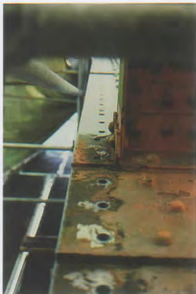
Bogenobergurt mit Fußpunkt der Steher, Ausbau der vorhandenen Niste unter Hitzeeinwirkung und starken Einschlägen, späterer Einbau der "Verstärkungslaschen"
