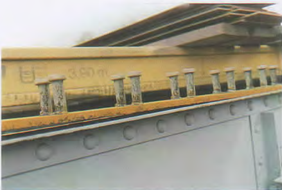
Verzogene Flacheisen mit aufgeschweißten Kopfbolzendübeln vor der Verschweißung mit dem Querträgerobergurt
