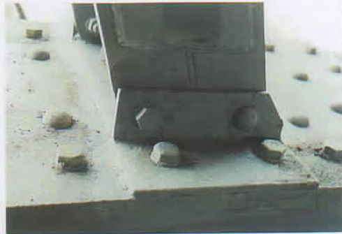
Fußpunkt der Steher, Verbindung mit Altnieten, neuen Schrauben, Schweißung
