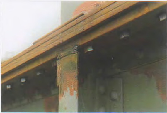
Hogenobergurt, Einbau der "Verstärkungsblechen" anstelle der ursprünglichen Niete werden Bolzen mit großem Spielraum eingebaut, Sandstrahlung bei den Altblechen wird nicht vorgenommen, Berechnung erfolgt für Gleitverbindung mit \mu = 0,5
