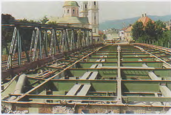
Nach Abtrag der Betonplatte, im Hintergrund die Ersatzbrücke
