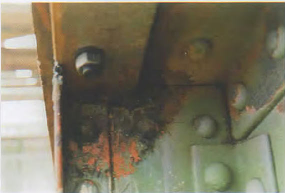
Hogenobergurt, Einbau der "Verstärkungsblechen" anstelle der ursprünglichen Niete werden Bolzen mit großem Spielraum eingebaut, Sandstrahlung bei den Altblechen wird nicht vorgenommen, Berechnung erfolgt für Gleitverbindung mit \mu = 0,5
