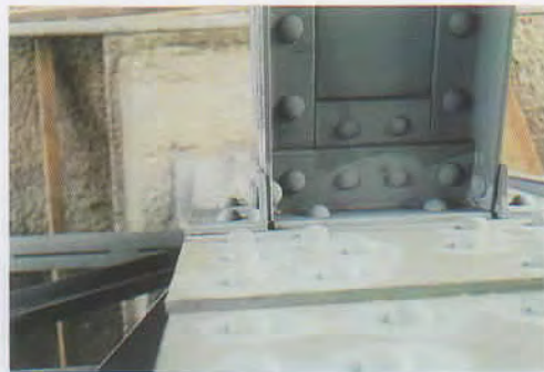
Fußpunkt Steher, Nietkopfverformung
