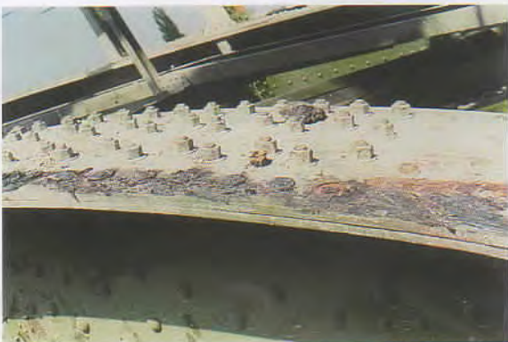
Auflagerbereich Bogen, Ausbau der Bolzen und Niete
