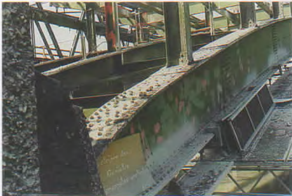
Randbogen, Entfernung der Bolzen und Nieten
