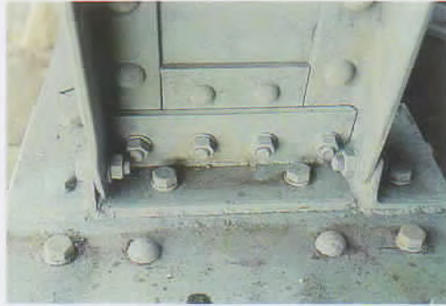
Fußpunkt der Steher, Verbindung mit Altnieten, neuen Schrauben, Schweißung
