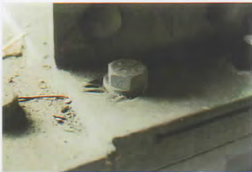
Fußpunkt Steher, neben Unterlagscheibe Ausschrüfung durch Nietentfernung
