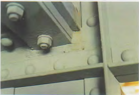
Geschraubte "Verstärkungsasche" bei genietetem Querträger durchgesteckt und voll verschweißt
