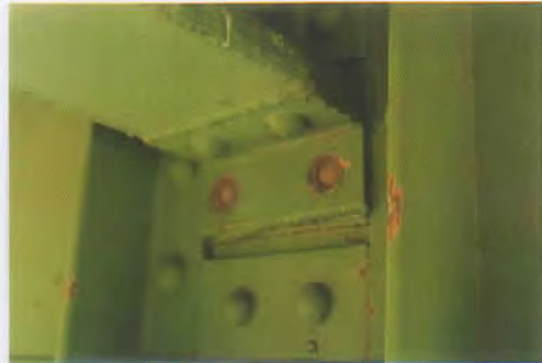
Anschluß Längsträger an Querträger, abgeplattete Nietköpfe
