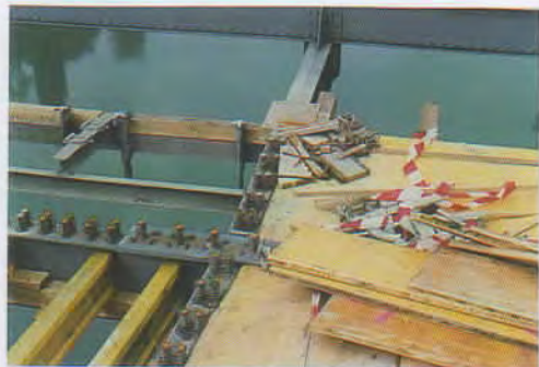
Aufgeschweißte Kopfbolzendübel auf Längsträger und Bogenobergurt, aufgeschweißte Flacheisen am Querträger mit Kragarm
