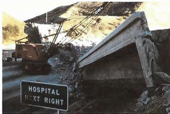
Abbildung 1: Brückeneinsturz nach dem San Fernando Erdbeben 1971 (Nielson, 2003)
