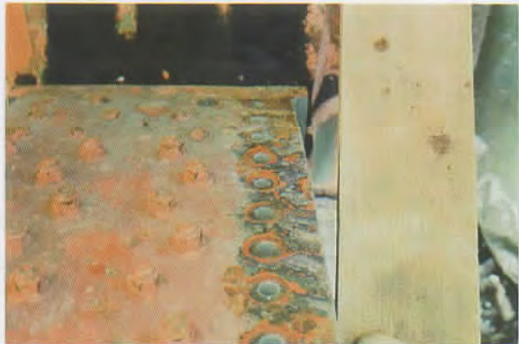
Bogenobergurt im Auflagerbereich, Ausschüfung und Ausbau der vorhandenen Bolzen unter Hitzeeinwirkung
