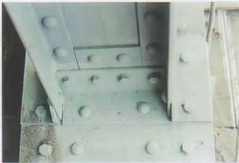
Fußpunkt der Steher, Verbindung mit Altnieten, neuen Schrauben, Schweißung
